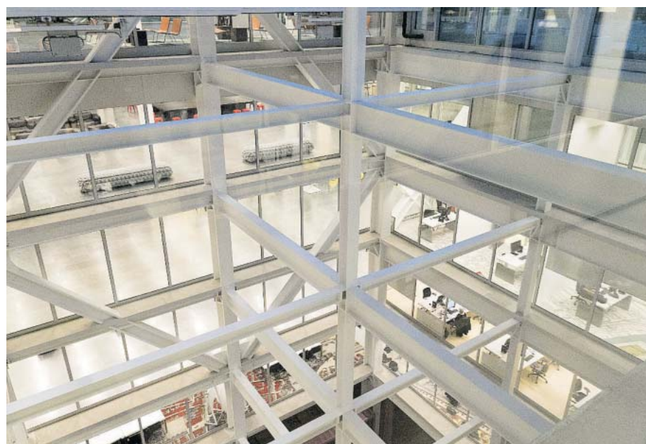
Aus Stahlmodulen gefertigt: Blick ins Timmerhuis
